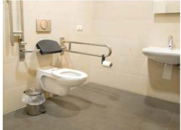
Foto 8: Ejemplo de dos agarraderas móviles en ambos lados.
