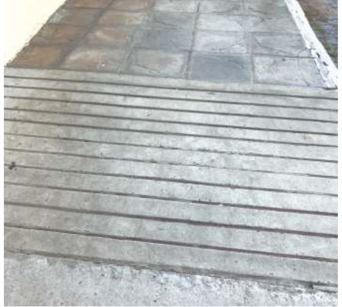
Foto 1: Pavimento de la rampa marcada en forma transversal y continua con líneas o canales.
